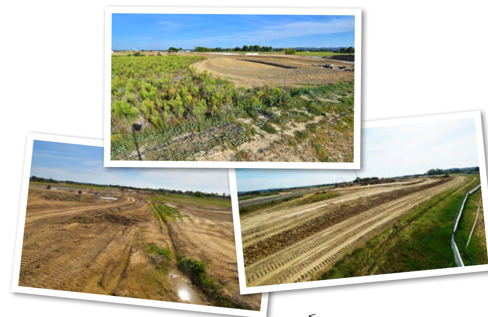
← Début des travaux généraux
