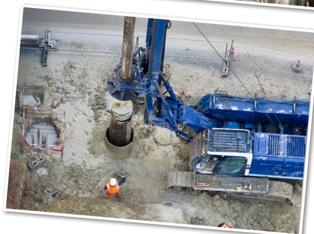
Forage pour réalisation des pieux en béton armé →
